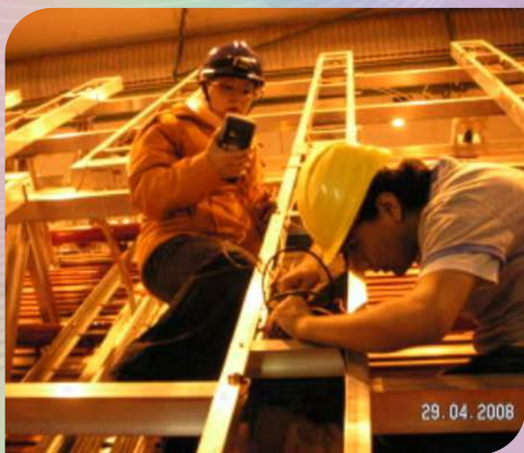
Instalación de centelladores ACORDE sobre el magneto de ALICE. En la foto: Mario Rodríguez (BUAP) e Ivonne Maldonado (UNAM).
