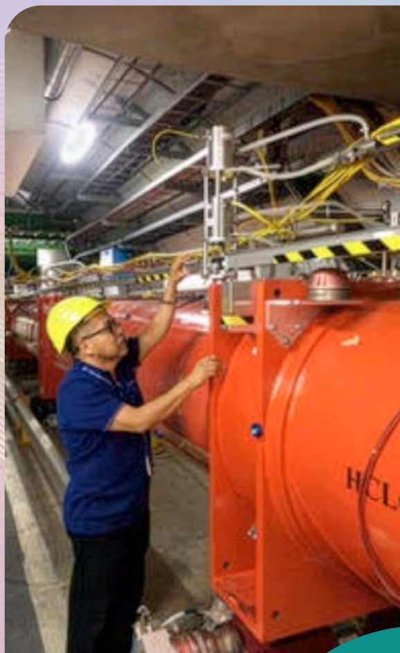
Arturo Fernández en el túnel del LHC, inspeccionando el sistema electromecánico.
